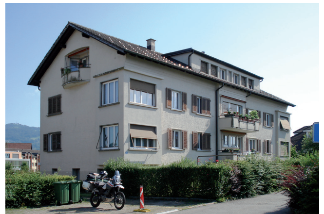
Vor einer Sanierung der Aussenhülle...
