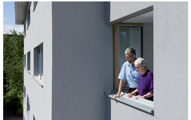
Mehr Wohnlichkeit und weniger Energieverbrauch dank Fenstern mit Dämmung und sanierter Fassade.
